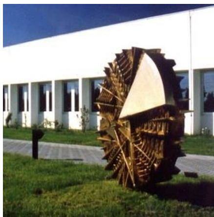
Scorcio della Sede Didattica di Ingegneria
