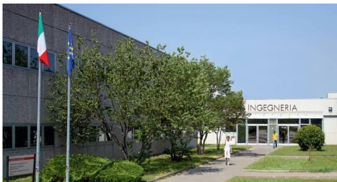
Ingresso della Sede Scientifica di Ingegneria
