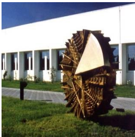
Scorcio della Sede Didattica di Ingegneria
