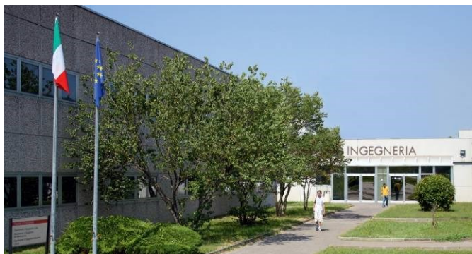
Ingresso della Sede Scientifica di Ingegneria
